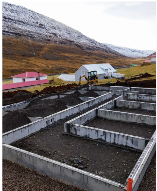
Hótelbygging að rísa við Óbyggðasetur.
