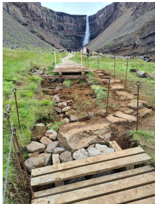
Mynd 10: Pallar fjarlægðir og hellulagt meðfram. Ljósmyndari: Rán Finnsdóttir.
