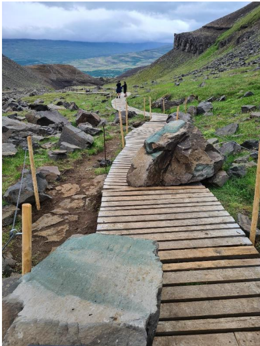
Mynd 11: Pallar réttir af og hellulagt meðfram. Ljósmyndari: Rán Finnsdóttir.
