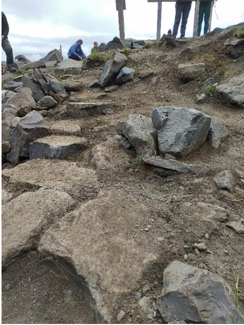
Mynd 13: Steintröppur lagðar niður í árfarveg Hengifossár. Ljósmyndari: Lea sjálfboðaliði.
